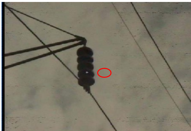
شکل ( ۱۰ ) – پانکچر ( Puncture Bell ) مقره چینی خط انتقال ۱۳۲ کیلوولت
