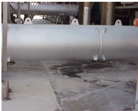
شکل - ۱۵ : آشکار سازی عیب عایق حرارتی مسیر عبور سیال
