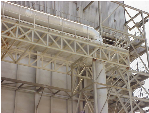
شکل - ۱۴ : خرابی عایق در نقاطی از خط انتقال سیالات
