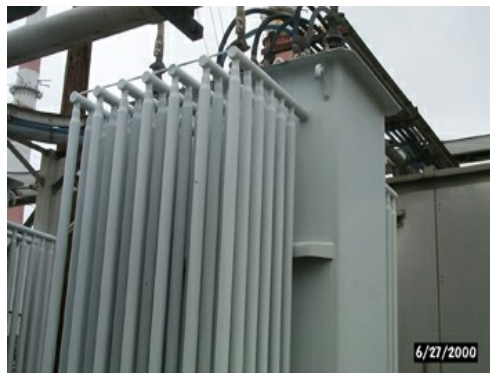
شکل - ۶ : عدم خنک کنندگی مناسب ترانسفورماتور در اثر کاهش سطح روغن
