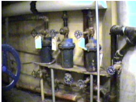
شکل - ۲۰ : نشت بخار در داخل یک تله بخار
