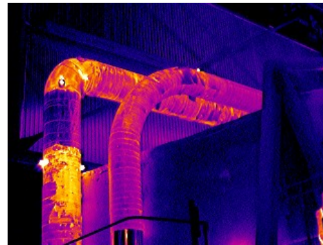
شکل - ۱۴ : خرابی عایق در نقاطی از خط انتقال سیالات
