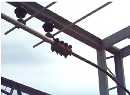
شکل - ۱۰: حرارت بیش از حد مجاز بر روی کلمپ موجود بر روی باس بار برق فشار قوی
