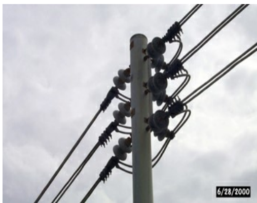
شکل - ۷ : خرابی Jumper در محل اتصال پیچها برروی هادی شبکه توزیع نیروی برق
