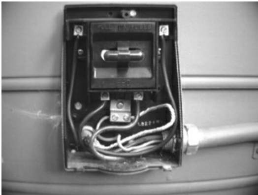
شکل - ۹: آشکار سازی محل عیب در جعبه تغذیه برق یک وسیله برقی
